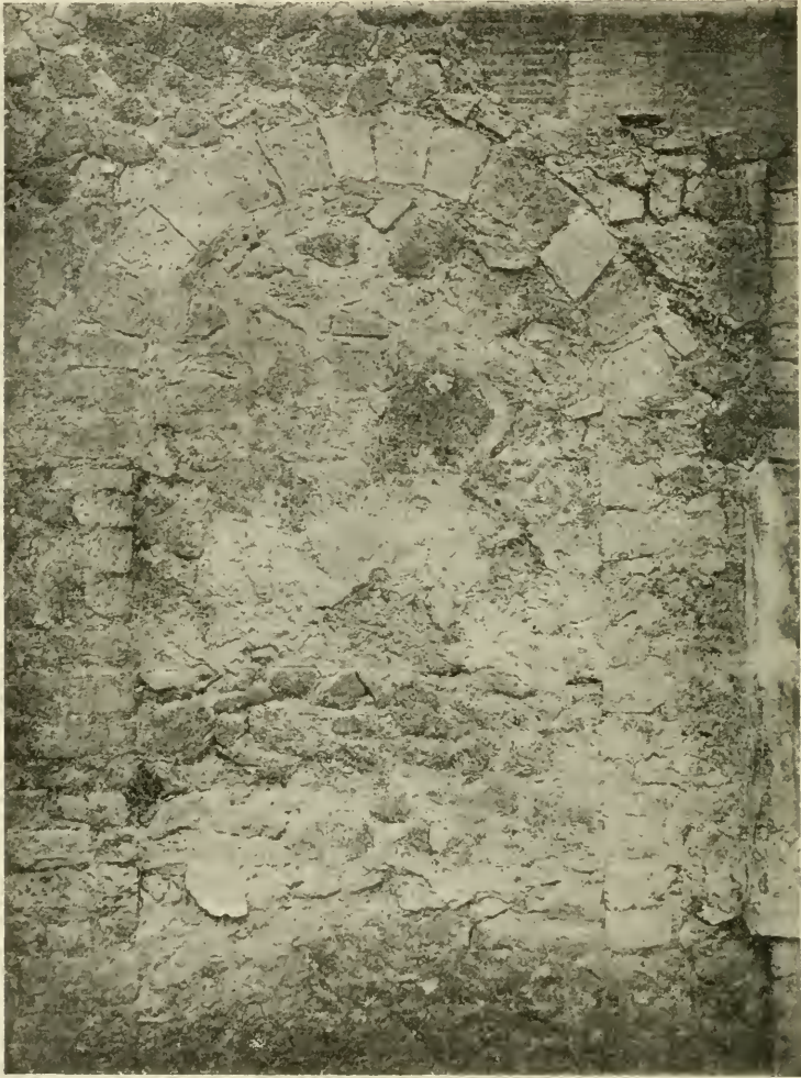
Fig. 9. — Westlichste vermauerte Thür von aussen.
